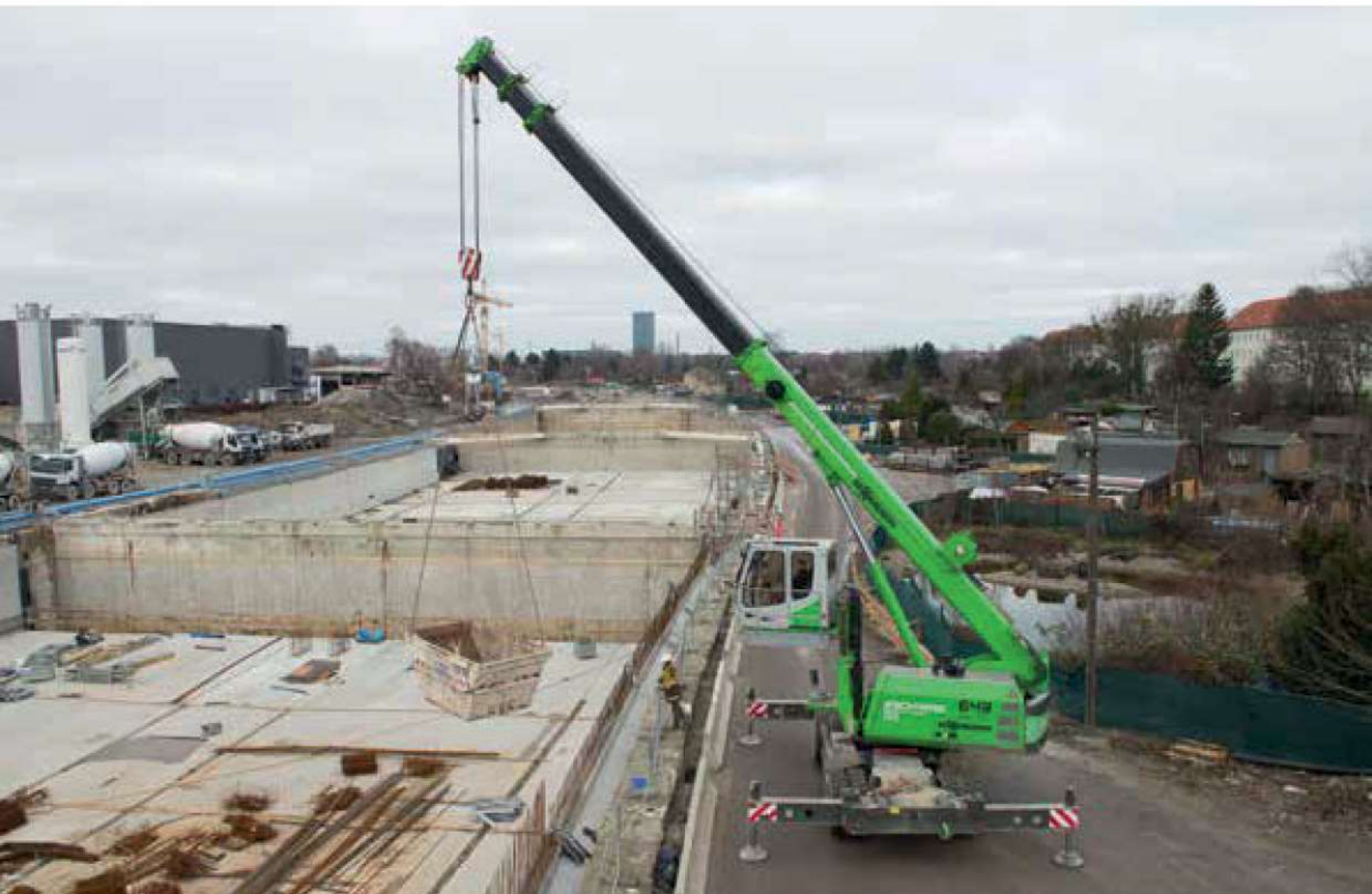
643 M - lifting tasks on construction site with vertical cab adjustment; Germany 643 M - Hebeaufgabe im Tiefbau mit vertikaler Kabinenverstellung; Deutschland
