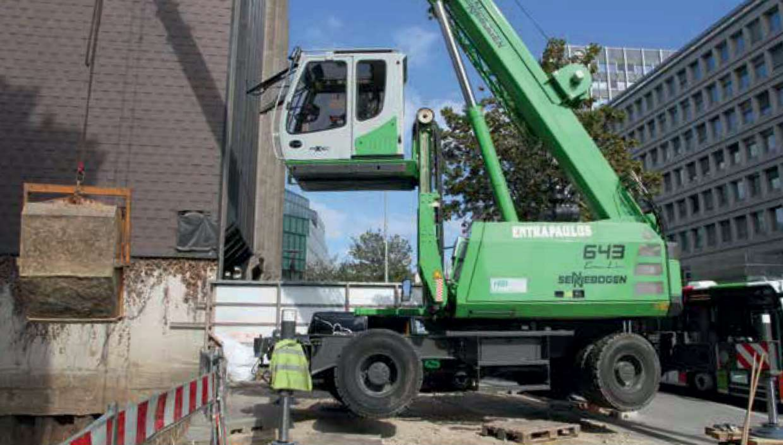
643 M - lifting tasks with vertical cab adjustment; Luxembourg 643 M - Hebeaufgaben mit vertikaler Kabinenverstellung; Luxemburg
