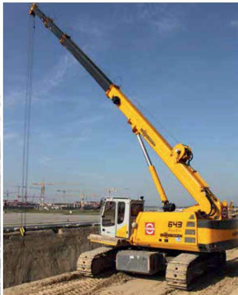
643 R - flexibility at civil engineering; Germany 643 R - Flexibilität im Tiefbau; Deutschland
