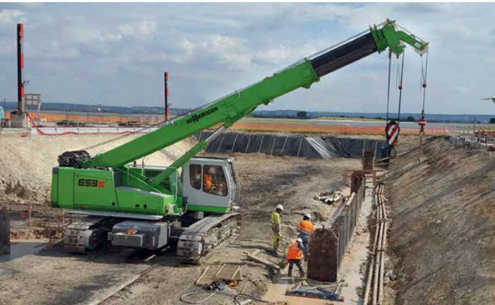
653 R - Civil and underground engineering at an airport; France 653 R - Tiefbauarbeiten auf dem Flughafengelände; Frankreich
