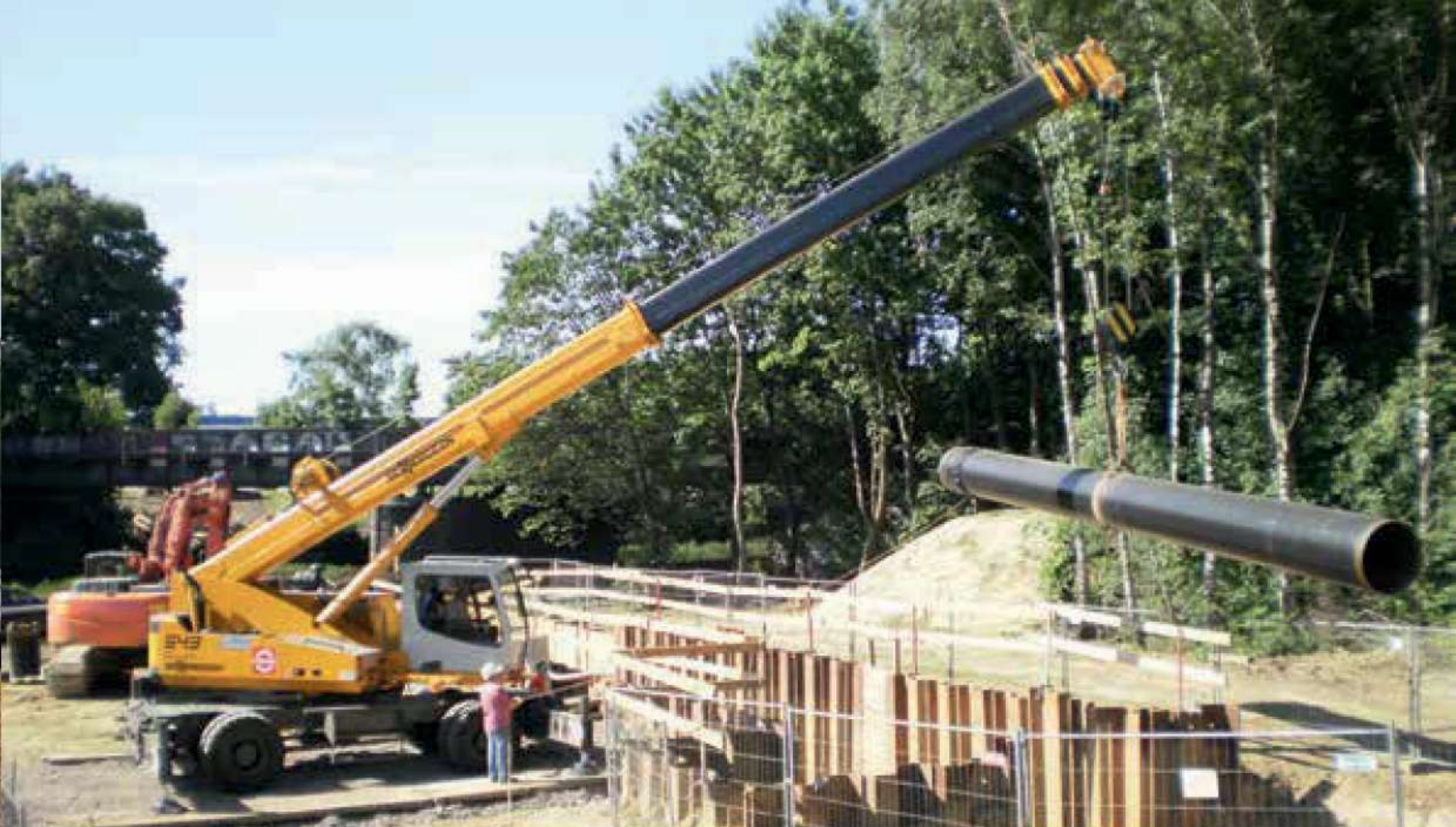
643 M - pipe installation works at civil engineerings; Germany 643 M - Rohrverlegung im Tiefbau; Deutschland
