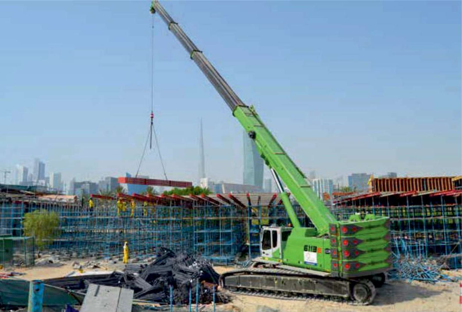
6113 R - in use on large construction sites in various lifting applications; Dubai 6113 R - auf Großbaustellen in diversen Hebeeinsätzen im Einsatz; Dubai
