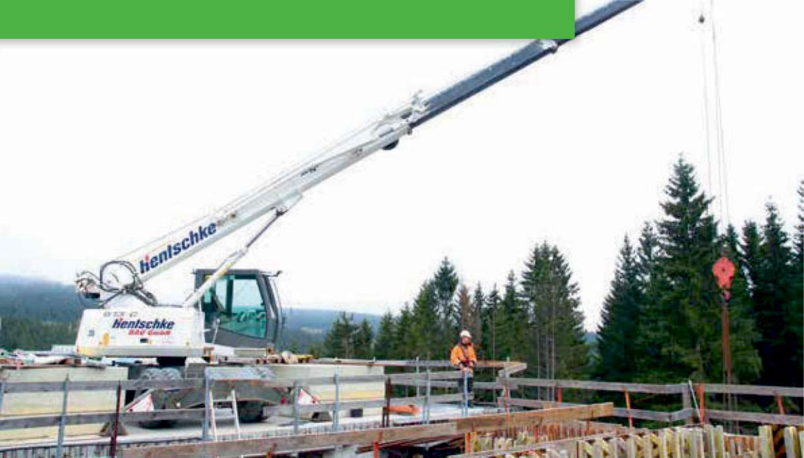
613 M - as auxiliary crane with remote control in bridge construction; Germany 613 M - als Hilfskran mit Fernsteuerung im Brückenbau; Deutschland
