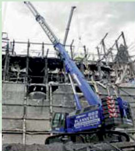
Demolition & Dismantling Abbruch & Rückbau
