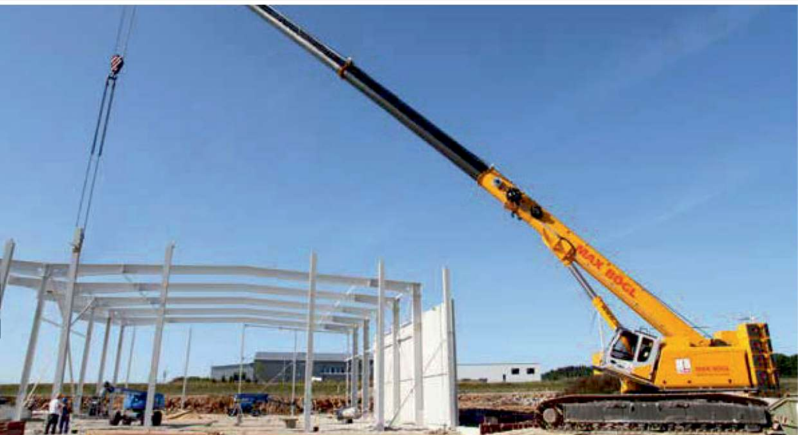
6113 R - secure positioning and setting of concrete piers, even with large working radii 6113 R - Betonpfiler auch bei großen Arbeitsradien sicher positionieren und setzen
