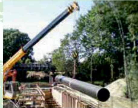
Pipe installation works Rohrlegearbeiten
