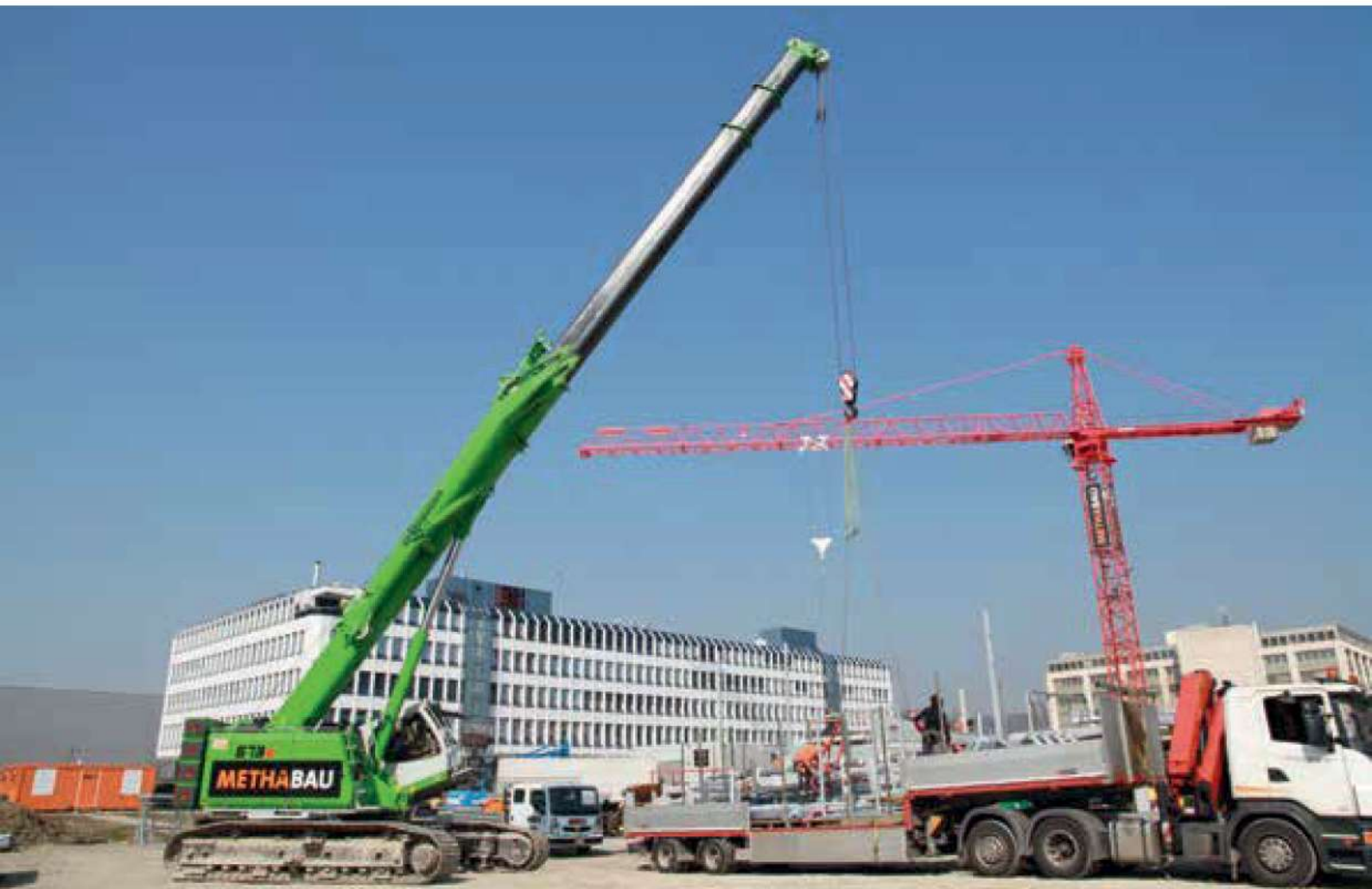
673 R - components of trucks unloaded and transported; Switzerland 673 R - Komponenten von LKW entladen und verfahren; Schweiz
