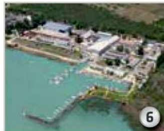
Works Balantonfüred, Hungary: Welding/steel structures Werk Balantonfüred/Ungarn: Schweiß-/Stahlbaugruppen
