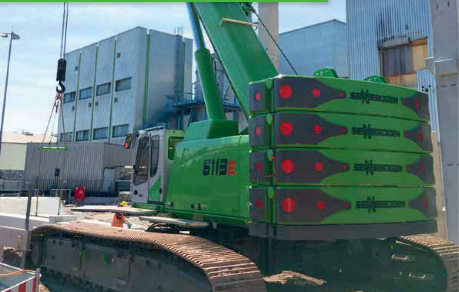
6113 R - service crane operations for heavy duty foundation jobsite; Paris 6113 R - Einsatz als Servicekran für Schwerlast-Einsatz; Paris
