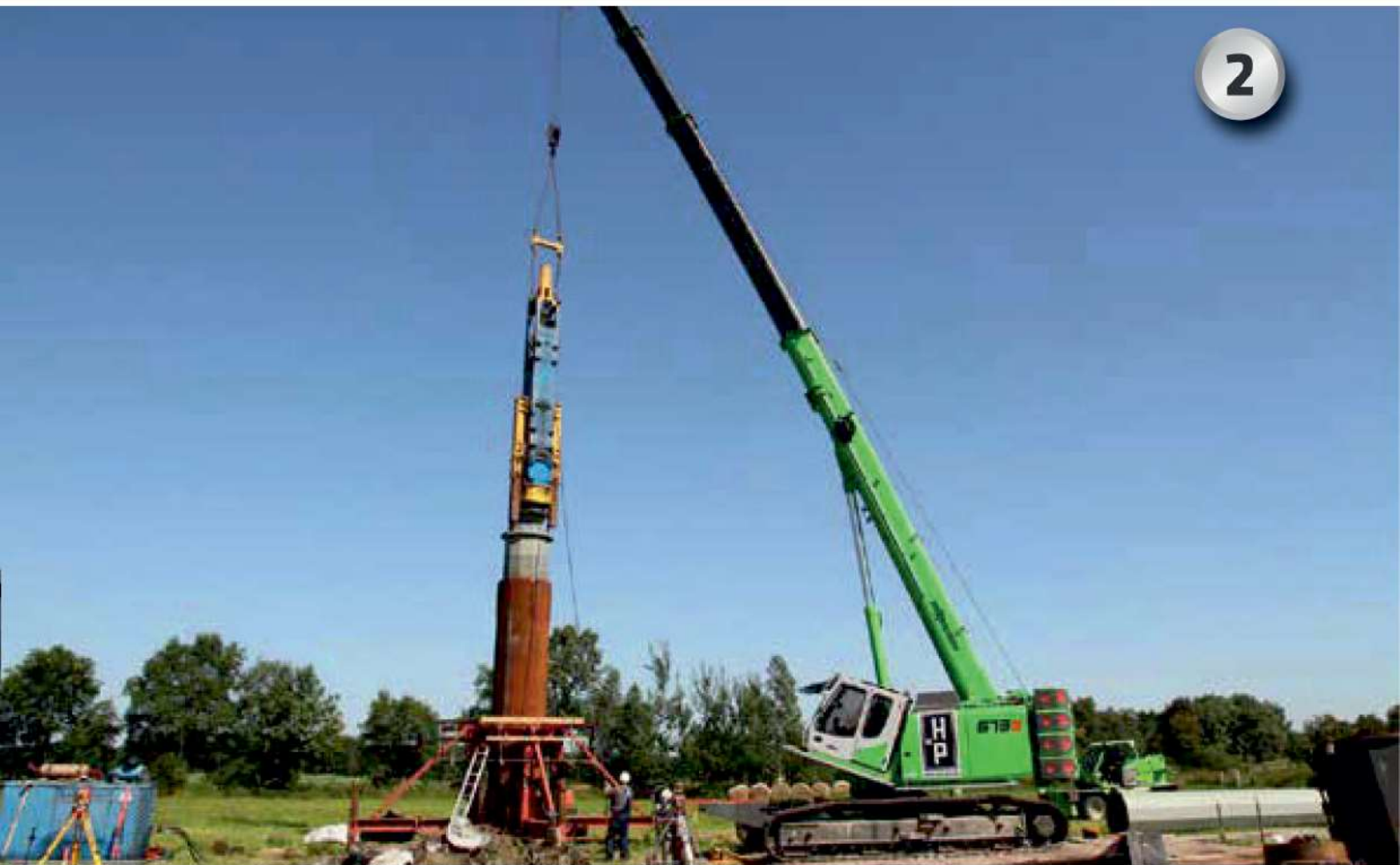
... and use the vibrohammer to bring it back to the ground; Germany ... und mit Rüttler in den Boden einbringen; Deutschland
