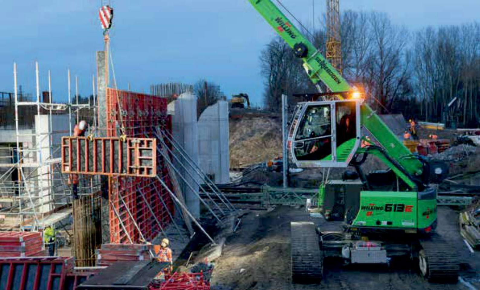
613 R - maximum safety when lifting loads in infrastructure construction thanks to the elevating cab; Germany 613 R - maximale Sicherheit beim Heben von Lasten im Infrastrukturbau dank hochfahrbarer Kabine; Deutschland
