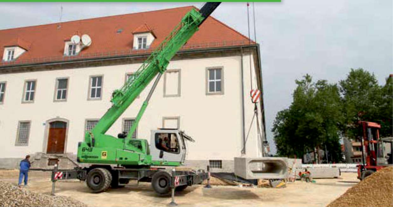
643 M – lifting heavy concrete-prefabricated parts; Germany 643 M – Heben von schweren Betonfertigteilen; Deutschland
