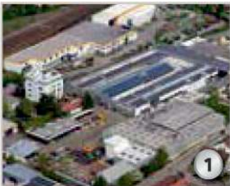
Works 1, Straubing: Company headquarter Werk 1, Straubing: Unternehmenssitz
