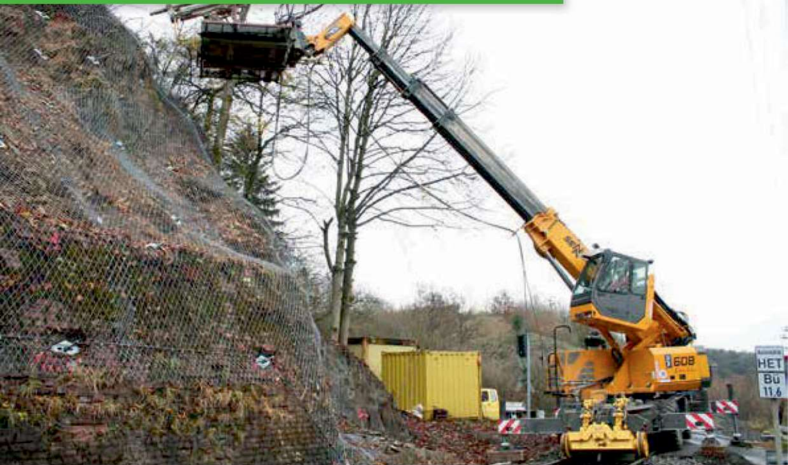
608 M - slope stabilization with drill carriage and rail boogies; Germany 608 M - Hangsicherung mit Bohrlafette und Schienen-Boogies; Deutschland
